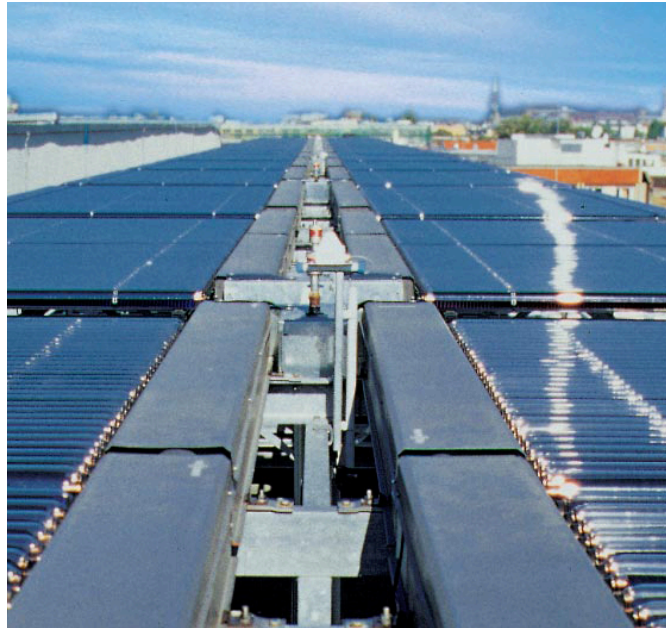
Vitosol 200 Kollektoren mit einer Absorberfläche von insgesamt 240 Quadratmetern sorgen für kühle Luft und unterstützen die Heizung im Bundespresseamt.
